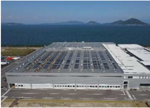
香西工場屋上の 太陽光発電設備
