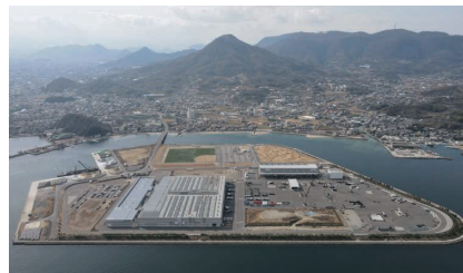
香西工場に設置した太陽光発電
