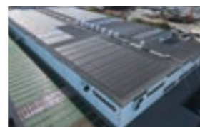
太陽光パネルの設置(多度津工場)
