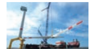
港湾での風力発電設備組み立て
