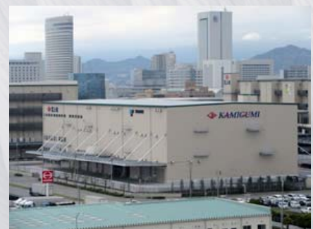
タダノ・グローバル・パーツセンター外観 (神戸市ポートアイランド)
