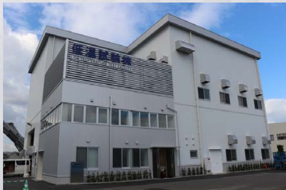
低温試験棟 外観
