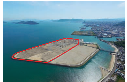
当社用地は赤枠部分。遠景に屋島を望む。 (高松市中心部より西に車で約10分。本年5月撮影。)
