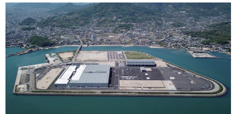
本年8月稼働開始予定の香西工場 [高松市] 建設用クレーンおよびブーム・シリンダ等主要部品を製造予定 (北側から望む)
