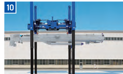
クレーンキャリア搬出完了。
