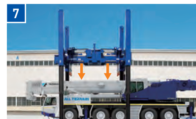
ジャッキをオールテレーンクレーンの所定位置まで下げて、リフターとブームを接続する。
