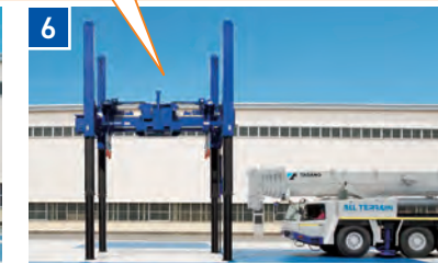
リフター内へオールテレーンクレーンを搬入する。
