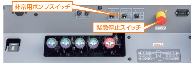
車両後端操作部
