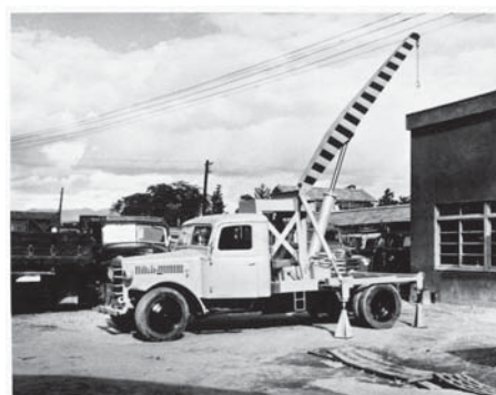
油圧式トラッククレーン1号機 OC-2 型
