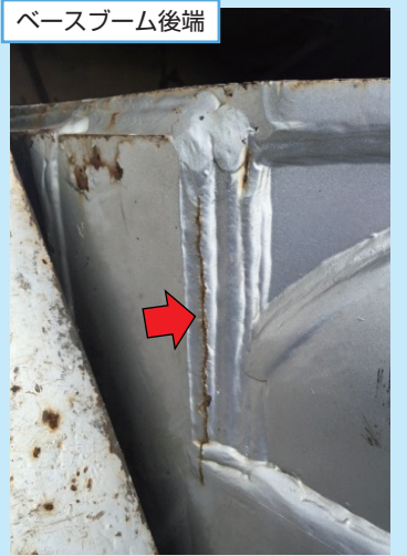
旋回フレーム側板継ぎ部
