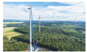
風力発電設備組み立て
