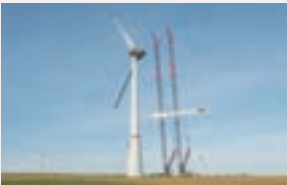
風力発電設備組み立て
