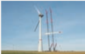
風力発電設備組み立て
