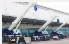
志度工場塗装棟
