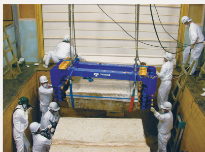
高松塚古墳石室解体
