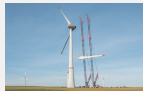
風力発電設備組み立て
